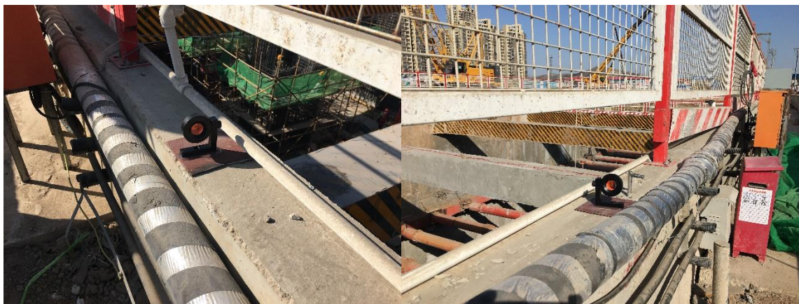
图 8.6 基坑南侧小棱镜布设实例图
